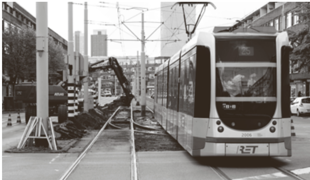
Tram 25, hier tijdens werkzaamheden op de Schieweg. (foto: RET)
